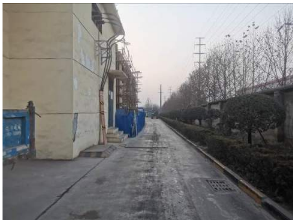
厂区原有排水
