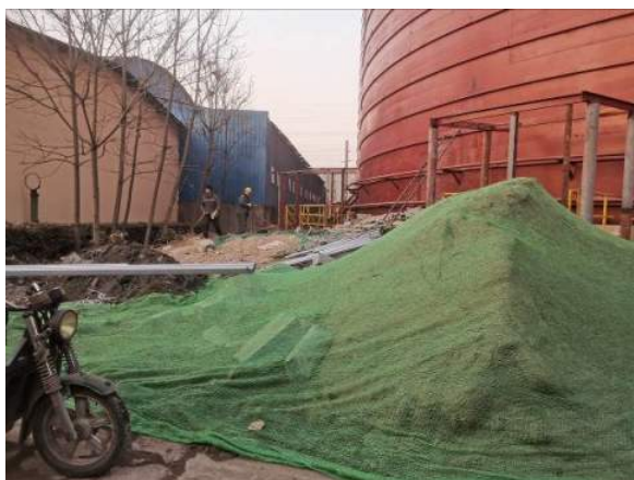
施工临时苫盖
