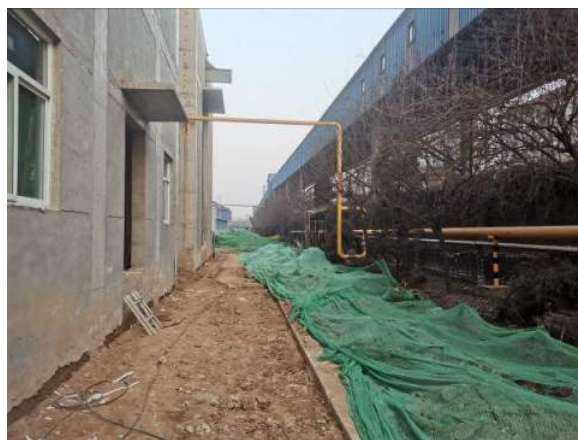
天然气管线施工区域
