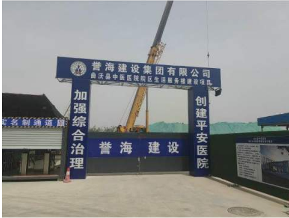
项目施工区入口
