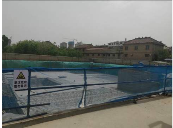
生活服务楼基坑
